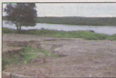
Erosão - (desmatamento de mata ciliar)
