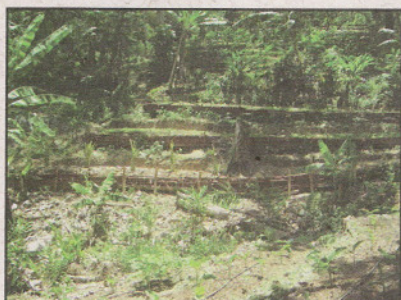
Construção de terraços
